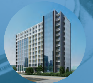
三河铭泰数据中心
