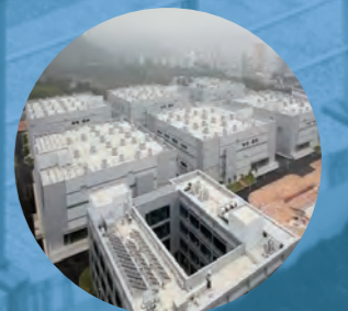
深圳联通深汕数据中心
