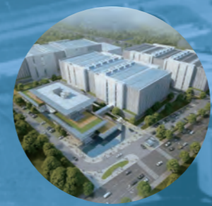
常熟万国数据中心
