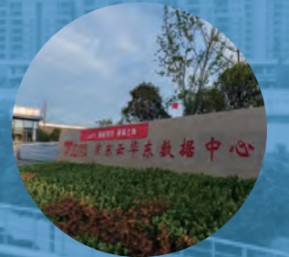
京东云华东数据中心
