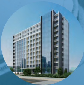
三河铭泰数据中心
