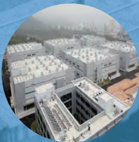
深圳联通深汕数据中心
