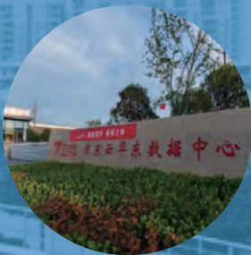
京东云华东数据中心
